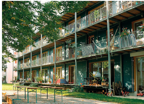
Abb. 22 : Passivhaus (Quelle: https://www.passivhaus-vauban.de/passivhaus.html )
