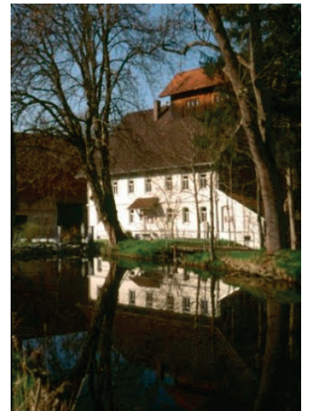
Abb. 4 : Franzenmühle (Quelle: https://www.franzenmuehle.de/gallery.html )
